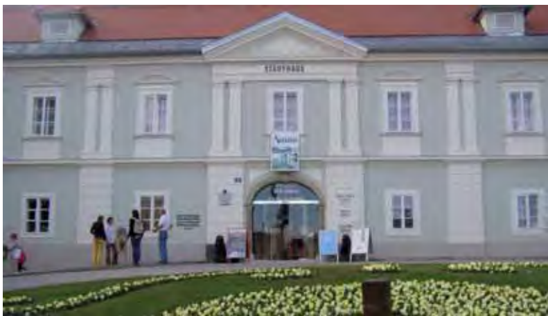
La Stadthaus di Klagenfurt (Foto: Denis Filaferro)
